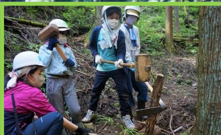
かけやで杭を打って道の土台作り
